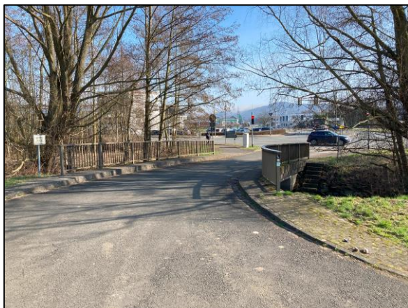
Abb. 3: Kreuzungsbereich der B 453 mit Brücke
