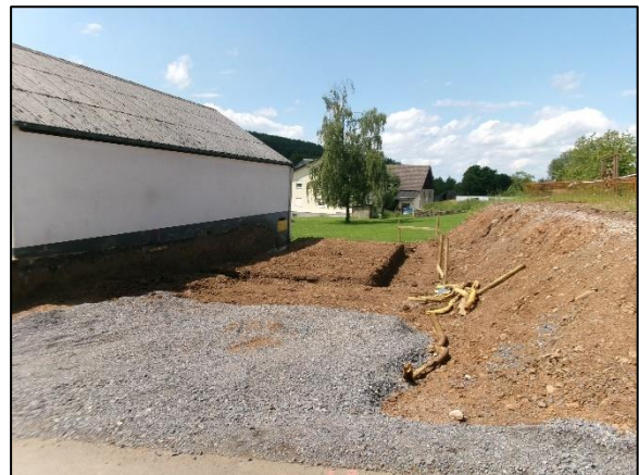
Abb. 17: Baustelle mit Rohbodenfläche im Süden des Plangebietes (eigene Aufnahme, 06/2024).
