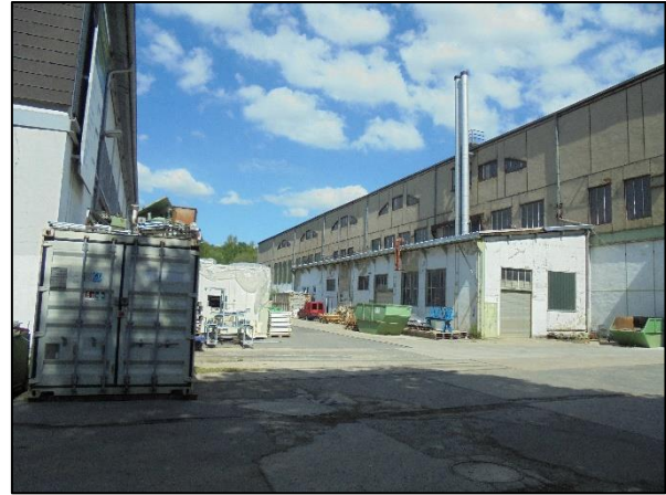
Abb. 12: Stell- und Lagerflächen zwischen den Werkhallen
