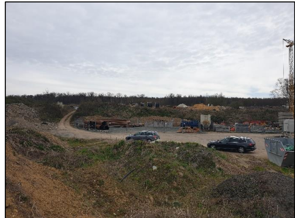
Abb. 20: terrassierte Lagerfläche im Norden des Plangebietes
