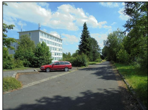
Abb. 16: Verkehrsflächen im Westen am BAMAG-Gebäude
