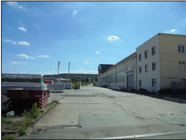
Abb. 13: Stell- und Lagerflächen im Osten
