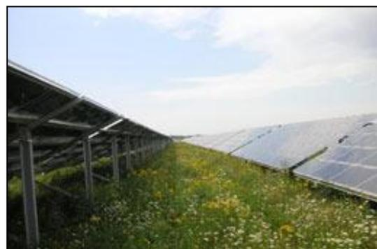
**Abb. 13:** Beispiel für aufgeständertes Modulfeld
