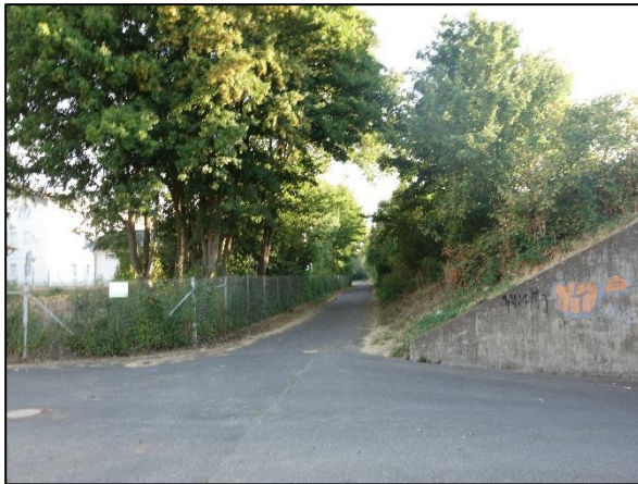
Abb. 21: Breite des im Plangebietes liegenden Radweges in Blickrichtung Norden sowie Kreuzungsbereich an der südlich des Plangebietes liegenden Unterführung.
