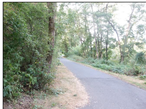
Abb. 26: An der nördlichen Unterführung anschließender Kreuzungsbereich der Radstrecke Lollar-Wettenberg.
