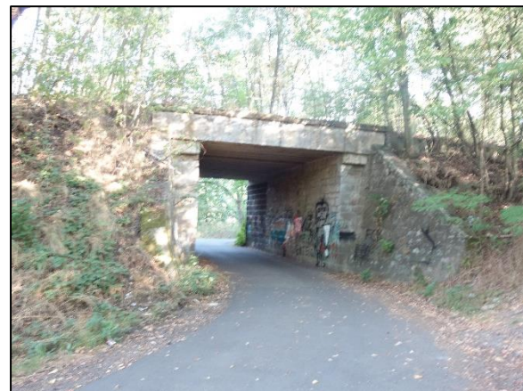
Abb. 24: Schmale Unterführung im nördlichen Bereich des Plangebietes.
