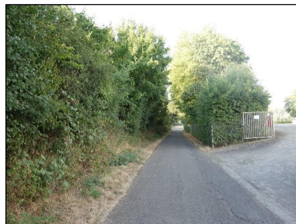
Abb. 12: Im Plangebiet liegende Straßenverkehrsfläche (Blickrichtung Süden).
