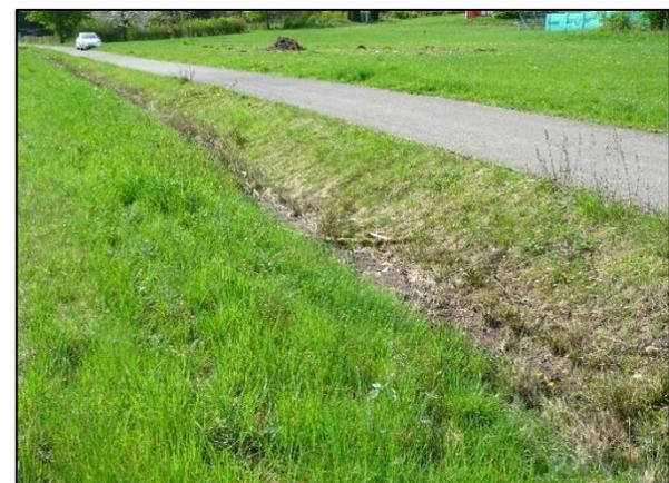
**Abb. 9:** In Nord-Süd-Richtung zwischen Grünland und Rad- und Fußweg verlaufende Entwässerungsmulde (Aufnahme 04/2024)
