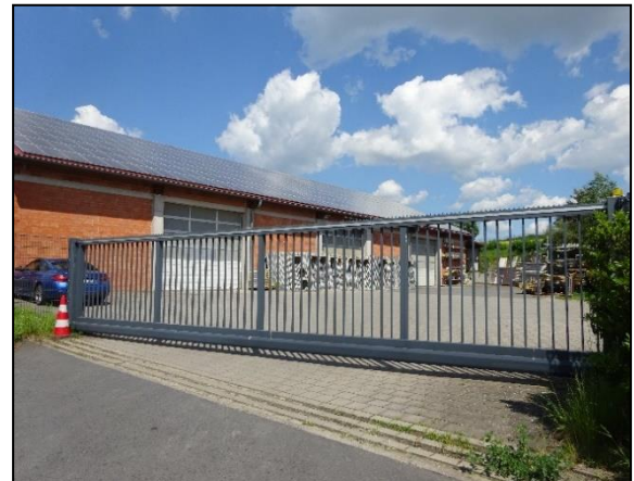
Abb. 14: Gewerbeanlage mit Pflasterfläche im Norden des Plangebietes (eigene Aufnahme 05/2024).
