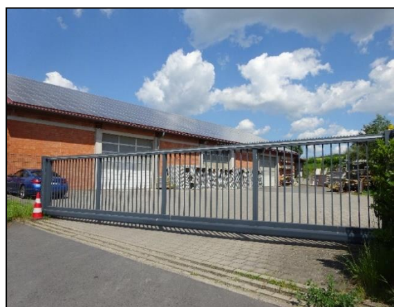
Abb. 14: Gewerbeanlage mit Pflasterfläche im Norden des östlichen Teilgeltungsbereiches (eigene Aufnahme 05/2024).
