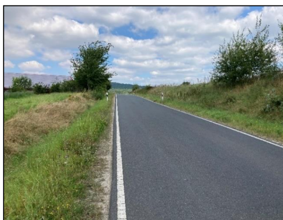
Abb. 13: Straßenbegleitgrün entlang der Hünfelder Straße (K12) innerhalb des östlichen Teilgeltungsbereiches (eigene Aufnahme 08/2024).
