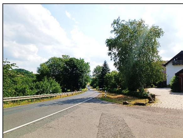
Abb. 13: Verlauf der Landesstraße L 3182 im östlichen Teil des Plangebietes. (eigene Aufnahme 07/2023)
