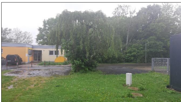
Abb. 11: Blick von Norden auf den Kindergarten (Mai 2024)
