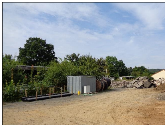
Abb. 11: Bauschutt und Ruderalflur im Süden des ehemaligen Sportplatzes.
