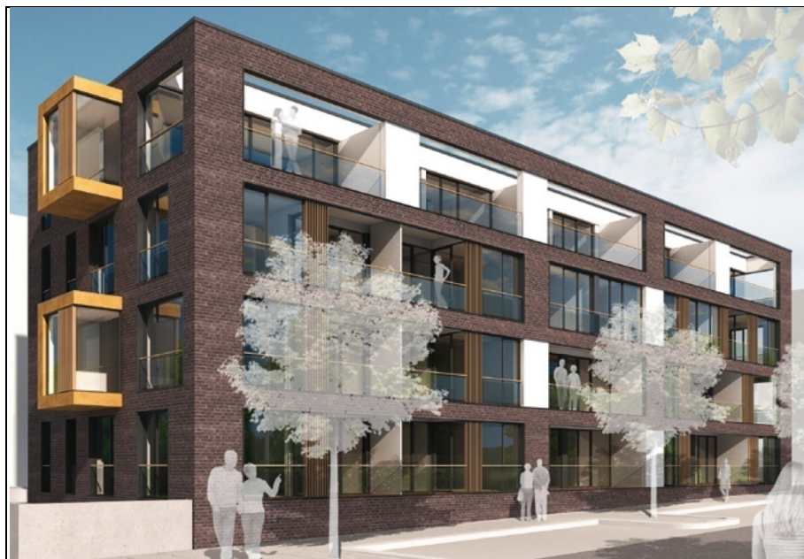
Abb. 8 : Loggien, die insbesondere gegen seitlich einfallenden Schall wirken.
