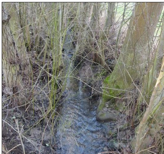
Abb. 25: Grünverbau am Aitzenbach
