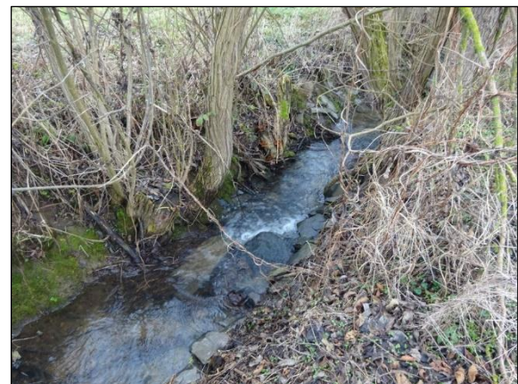
Abb. 26: Sohl- und Uferverbau mit Steinsatz
