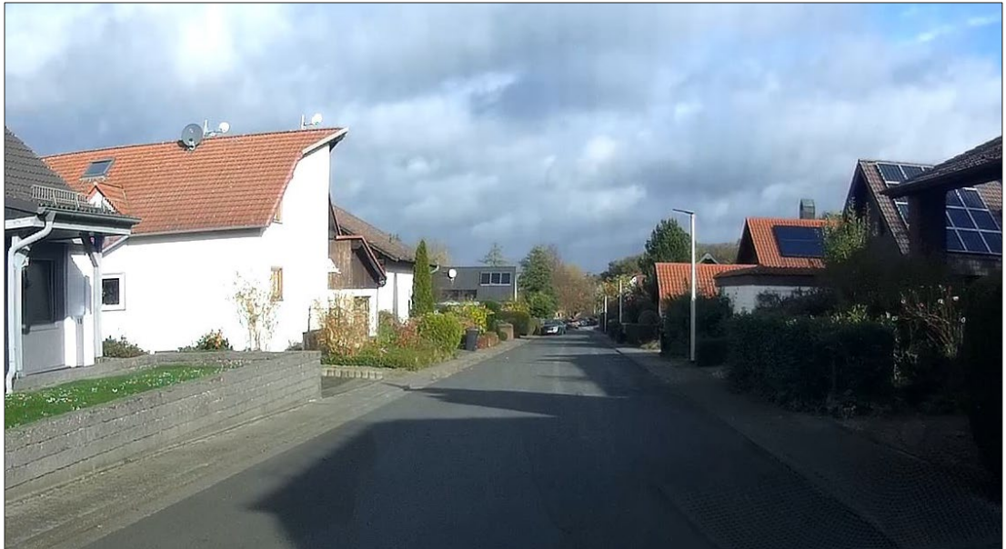
Bild 1: Vorhandener Ausbauzustand der Straße "Am Weiher"
