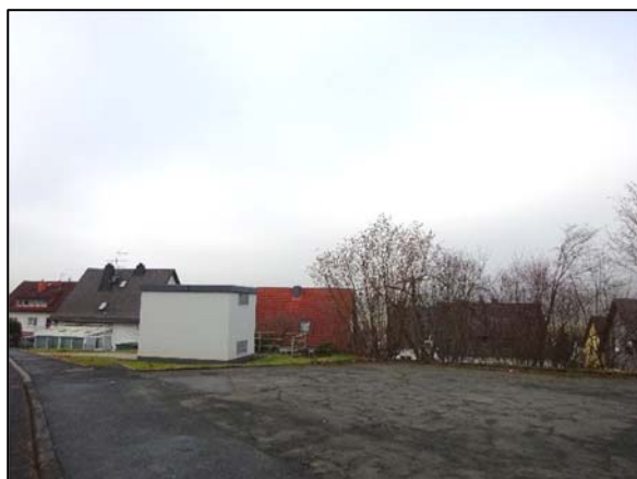
Abb. 14: Versiegelte Fläche mit kleiner öffentlicher Grünfläche und Trafostation im Hintergrund (eigene Aufnahme 01/2025)
