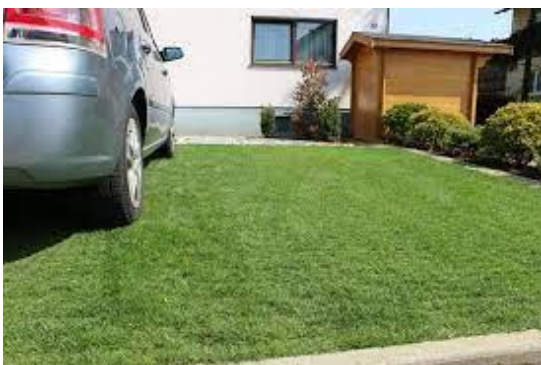
Abb. 12: Beispiel für eine wasserdurchlässig begrünte Stellplatzfläche
