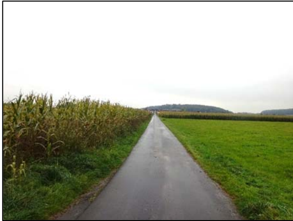
Abb. 11: Asphaltierter Wirtschaftsweg im nördlichen Teil des Plangebietes mit angrenzender Acker- und Grünlandfläche. Blick nach Südwesten (Aufnahme 10/2021).
