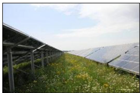
Abb. 13: Beispiel „Aufgeständertes Modulfeld“
