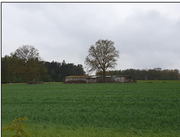
Abb. 3: Zentrale Scheune im Geltungsbereich
