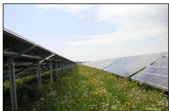
Abb. 13: Beispiel „Aufgeständertes Modulfeld“
