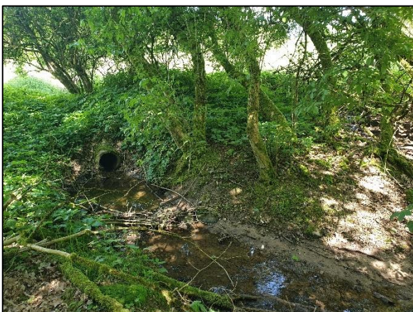
Abb. 12: Verrohrter Ausfluss aus dem Plangebiet am südlichen Ende des zentralgelegenen Grabens
