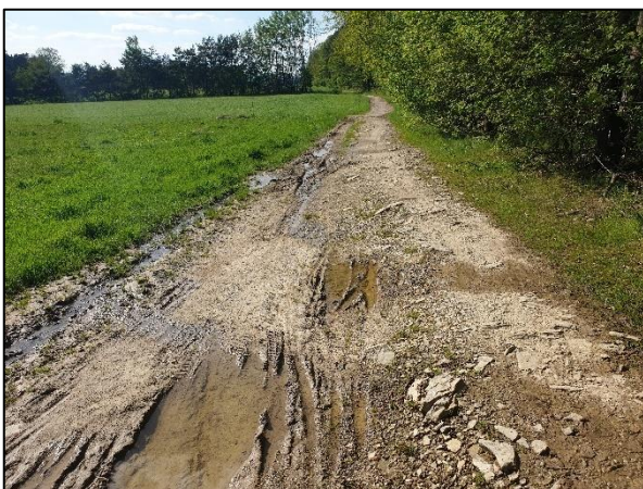
Abb. 19: Schotterweg entlang der nördlichen Plangebietsgrenzung
