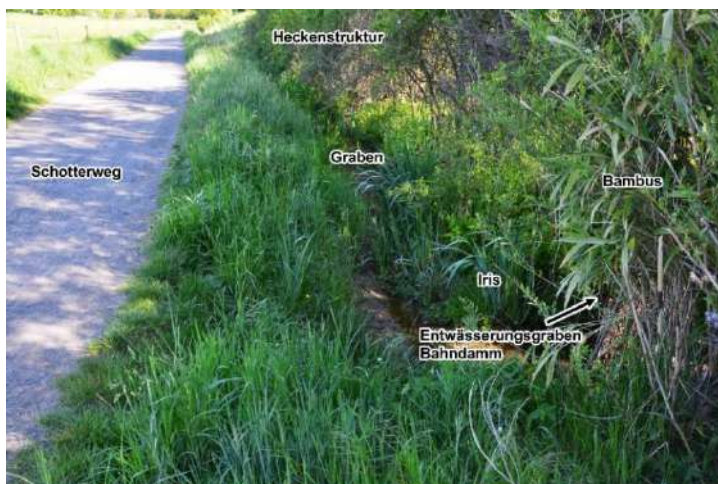
Foto 7 Graben zwischen Schotterweg und Heckenstruktur verbunden mit dem Entwässerungsgraben des Bahndamms (Aufnahme: 06.05.2022)
