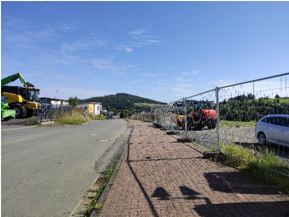
Absperrung der Baustelle
