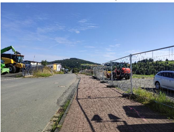
Absperrung der Baustelle
