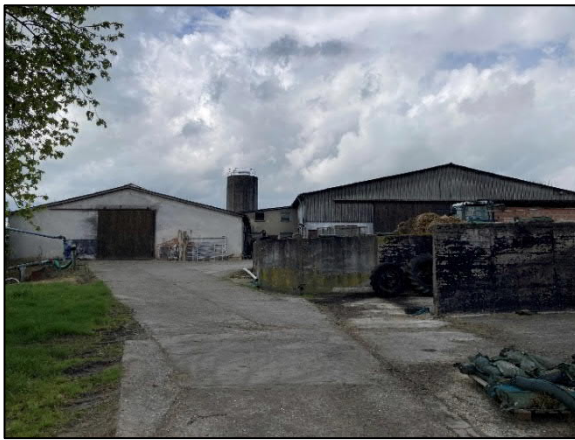
Abb. 12: Blick auf die Gebäude des landwirtschaftlichen Betriebs „Windhof“ (eig. Aufnahme 25.04.2024).
