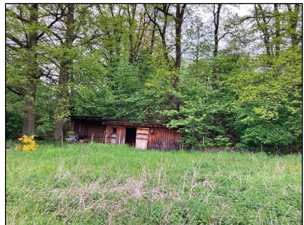
Abb. 17: Stall/Futterstelle am Rander der Wiesenbrache auf der unteren Ebene des Plangebietes, Blickrichtung von Süden nach Norden (eigene Aufnahme 05/2024).
