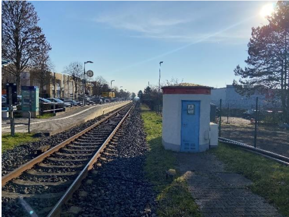
Blick nach Osten entlang der Gleise
