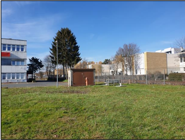
Abb. 11: Tiefbrunnen im Nordosten
