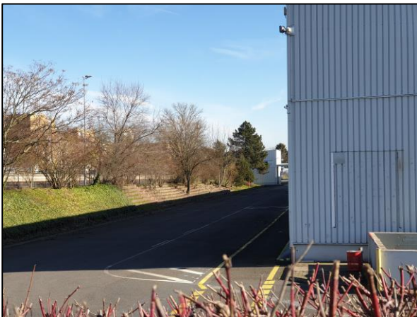
Abb. 15: Teilbefestigter Böschungsbereich entlang der Bahntrasse
