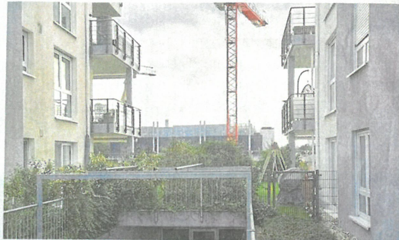
Hinter den Wohnhäusern im Hugo-Hoffmann-Ring erheben sich die Rechenzentren des Unternehmens NTT (ehemals e-Shelter). Zum Ärger der Anwohner seien die riesigen Datenspeicher nicht so lärmfrei, wie ursprünglich erhofft. FOTO: KRÖNER
