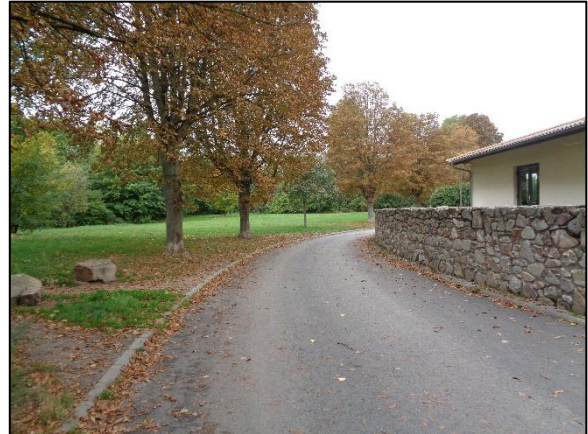
Abb. 4: Asphaltierte Straße im Süden des Plangebietes sowie teilweise in das Plangebiet hineinragende Grünfläche mit straßenbegleitenden Bäumen.
