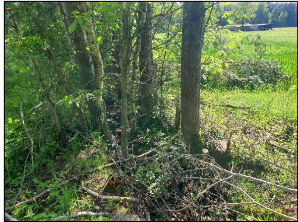
Abb. 19: Der Verlauf des zentralgelegenen Grabens ist bereits stark zugewachsen. Der Wasserabfluss verschwindet im weiteren Verlauf.
