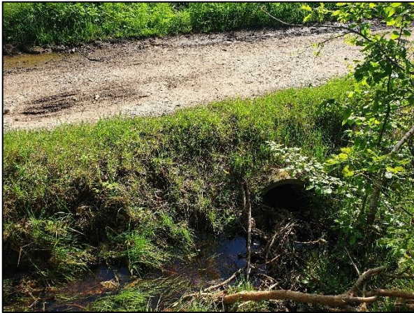
Abb. 18: Verrohrter Zufluss von der nördlich angrenzenden Waldfläche in den zentralgelegenen Graben
