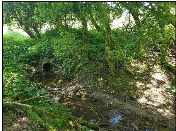
Abb. 15: Verrohrter Ausfluss aus dem Plangebiet am südlichen Ende des zentralgelegenen Grabens
