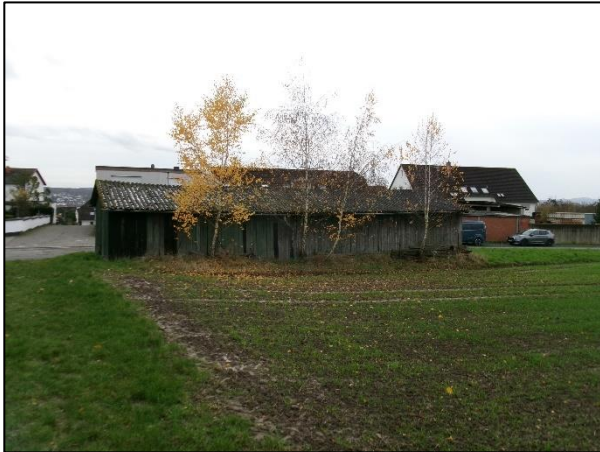
Abb. 11: Holzschuppen mit Birken im Südosten des Plangebietes (11/2024).
