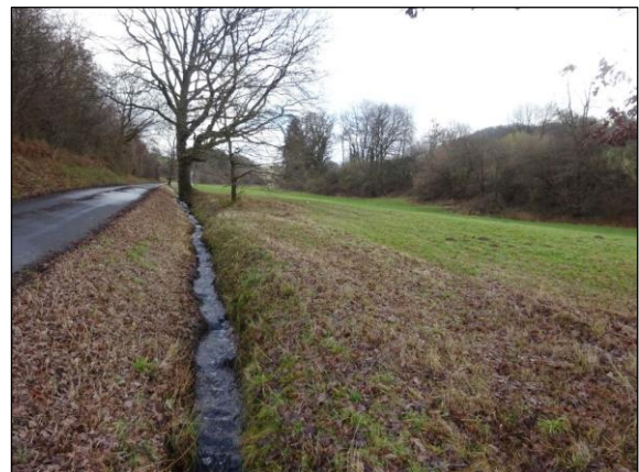
Abb. 12: Namenloses Gewässer zwischen Hof Tannenbergr und Hofgut Altenburg aus dem Taltiefsten in die Straßenentwässerungsmulde verlegt (eigene Aufnahme)
