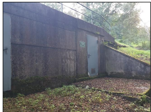
Abb. 76: Wasserwerk innerhalb der Teilfläche 3 (eigene Aufnahme 02/2023)
