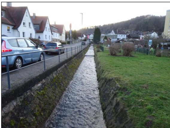
Abb. 11: Im Kastenprofil mit gepflasterter Sohle abgeführter Leimbach (eigene Aufnahme)
