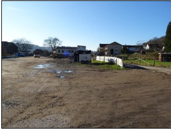
Abb. 46: Baufläche mit Schotterung im Bereich der Planfläche W 4 (eigene Aufnahme 02/2023)
