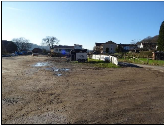
Abb. 136: Baufläche mit Schotterung im Bereich der Planfläche W 4 (eigene Aufnahme 02/2023)
