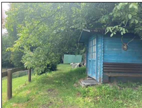
Abb. 55: Blick Gartenhütte und Apfelbaum (eigene Aufnahme, 06/2021)
