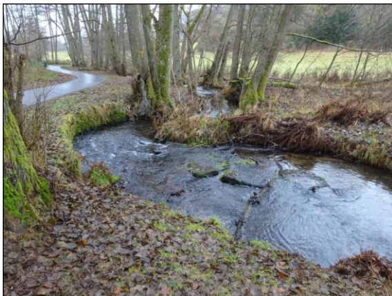
Abb. 7: Einseitige Ufermauern im Prallhangbereich der Orb zwischen Bachkilometer 6,7 und 8 (eigene Aufnahme)
