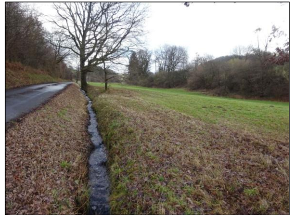
Abb. 12: Namenloses Gewässer zwischen Hof Tannenbergr und Hofgut Altenburg aus dem Taltiefsten in die Straßenentwässerungsmulde verlegt (eigene Aufnahme)
