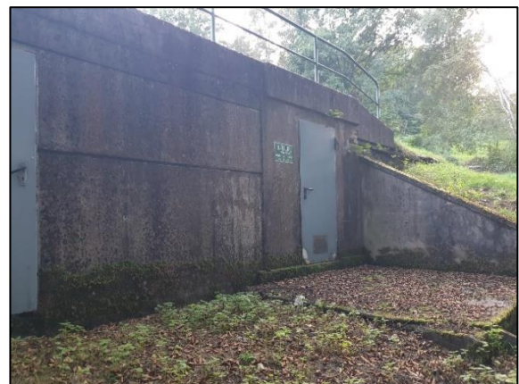
Abb. 166: Wasserwerk innerhalb der Teilfläche 3 (eigene Aufnahme 02/2023)
