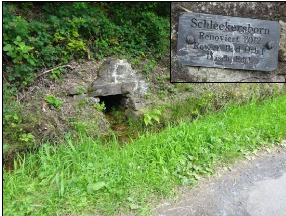
Abb. 17: Der „Schleckersborn“: Eine gefasste Quelle an der Haselstraße (eigene Aufnahme)
